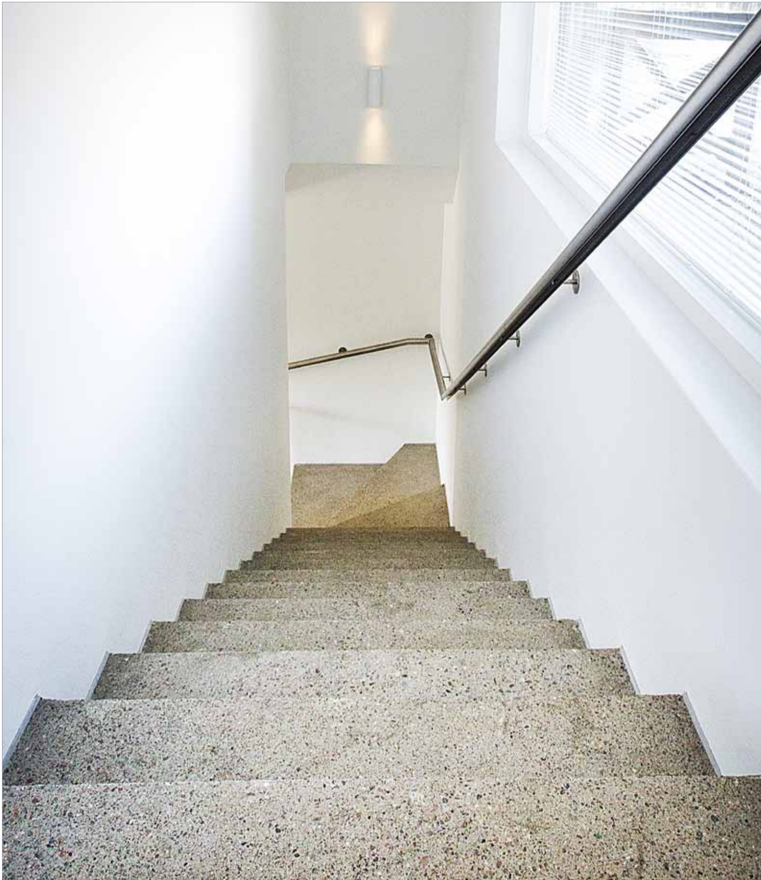
Kahden kerroksen välinen betoniportaikko halutaan säilyttää arkkitehtonisen puhtaana, eikä seinille laiteta tauluja. Portaat on käsitelty silikonipohjaisella betonipinnoitteella.
