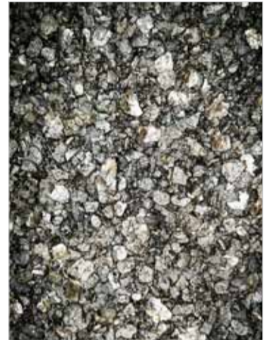
Eteisen seinän kivimäinen pinta.
